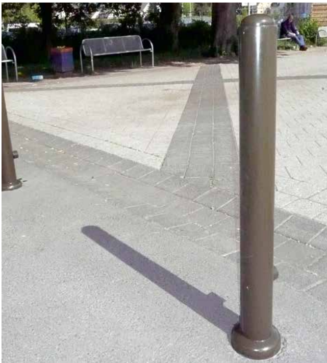
Stilpoller aus Stahlrohr Ø 82 mm ca. 800 mm Überflur, feuerverzinkt und beschichtet
